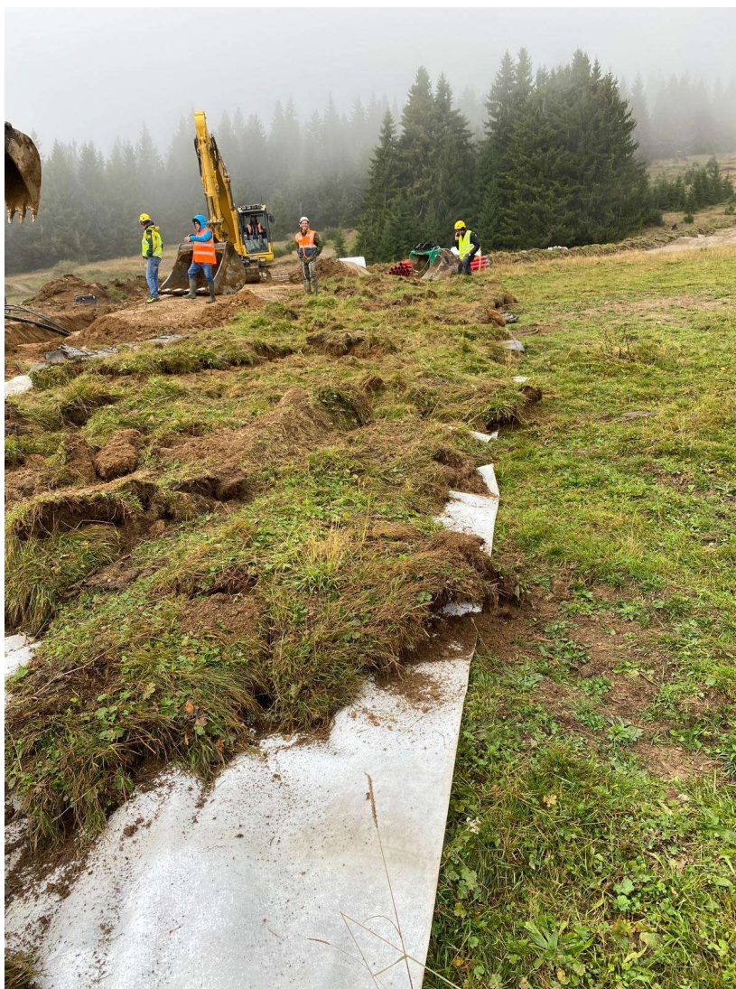
Exemple de stockage de la terre végétale sur tapis
